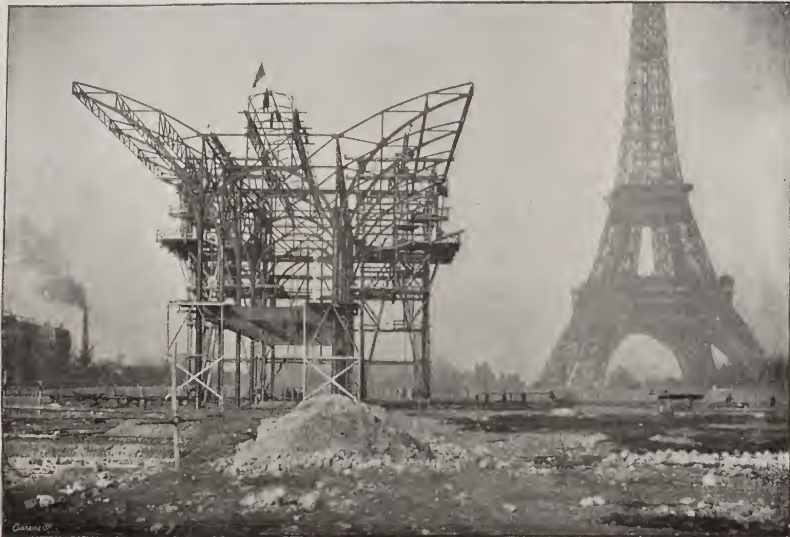
AU CHAMP-DE-MARS. — Les premières fermes du Palais du Génie Civil.
